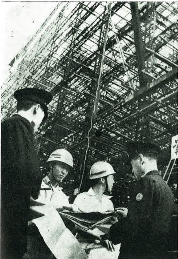
También se efectúan inspecciones a fábricas y edificios en construcción.
